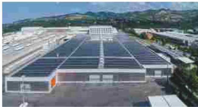
L'impianto visto dall'esterno.
