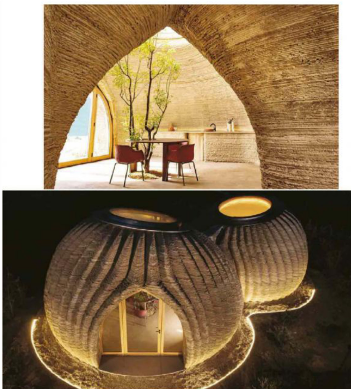
In alto, Tecla, case circolari costruite con stampa 3D in terra cruda, a Massa Lombarda, in provincia di Ravenna, 2021. Foto di Iago Corazza. A destra, dettaglio di One Airport Square, edificio ad Accra, Ghana, 2015. Foto di Fernando Guerra. Pagina a fianco, rendering del Museo di Arte Etrusca Fondazione Luigi Rovati, a Milano (progetto in corso).
