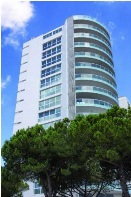
Questo permette a una facciata ventilata realizzata con questo materiale di rimanere pulita grazie alla sola azione combinata del biossido di titanio, che non permette a sporco e inquinamento di posarsi definitivamente sulla superficie ceramica, e della pioggia che dilava il resto. Il vantaggio così ottenuto è duplice: una facciata che **rimane pulita** nel corso degli anni anche negli ambienti più inquinati, e una spesa ridotta di manutenzione e pulizia ordinaria.
