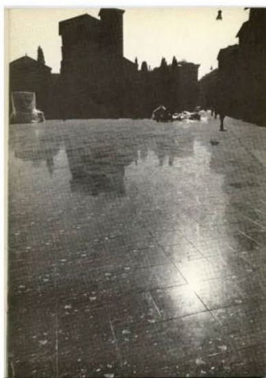
La piazza durante l'installazione dei lavori. Foto courtesy Gianni Ummarino.
