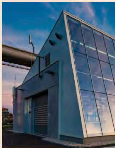
Site pilota. L'elettrolizzatore sperimentale di Voestalpine a Linz, in Austria. Ha una potenza di 6 MW e può produrre 1.200 metri cubi di idrogeno verde l'anno
